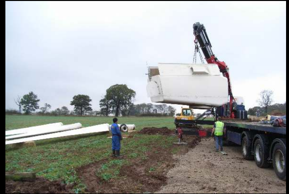
Unloading the nacelle
